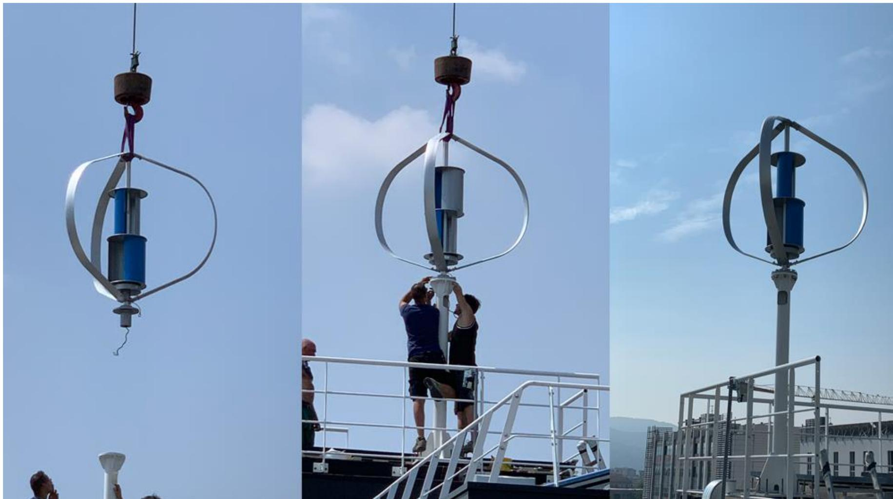
Il palo del generatore eolico ad asse verticale deve rispettare il disegno della flangia di connessione del generatore stesso, è possibile realizzare pali per tetto piano oppure pali a disegno previa valutazione.
